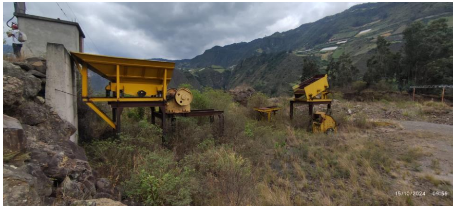
Fig. 4. Montaje inactivo, en estado de abandono
