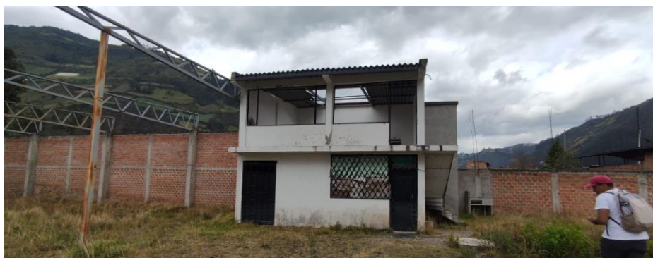
Fig. 6. Campamento, en estado de abandono
