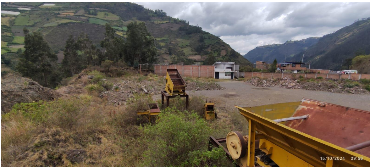
Montaje trituración, sin actividad minera.
