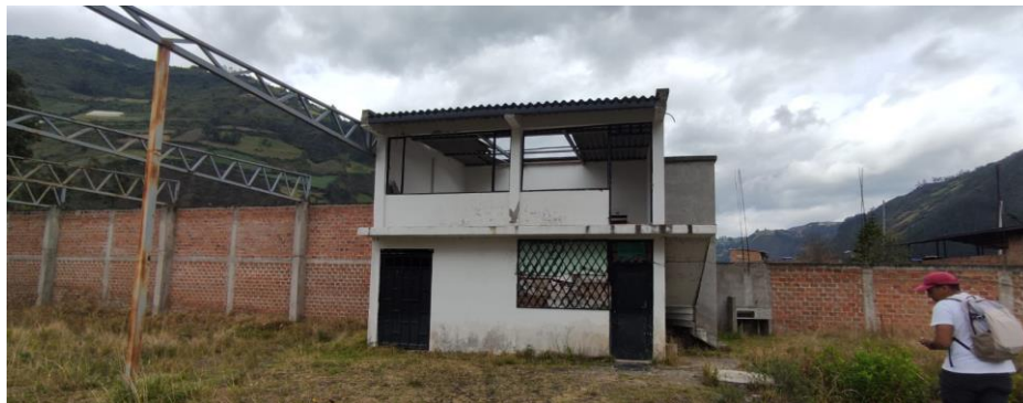
Fig. 6. Campamento, en estado de abandono
