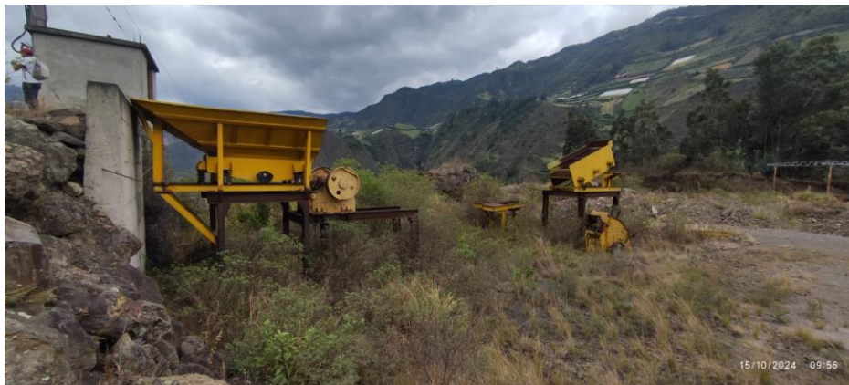
Fig. 4. Montaje inactivo, en estado de abandono
