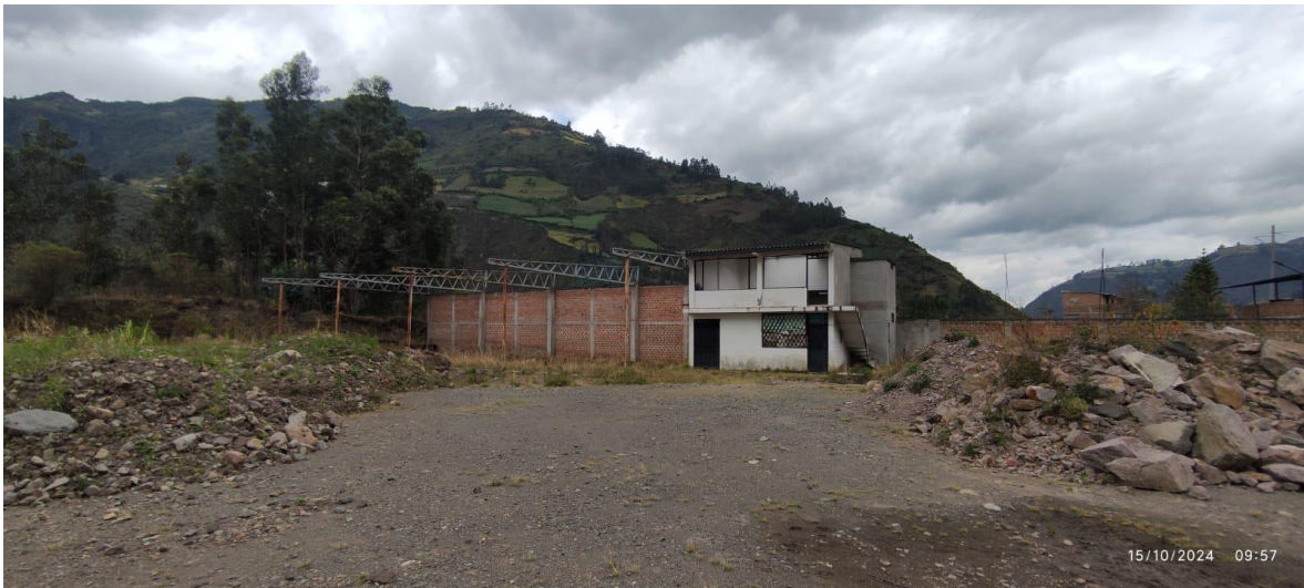
Infraestructura dentro del polígono minero, en estado de abandono.
